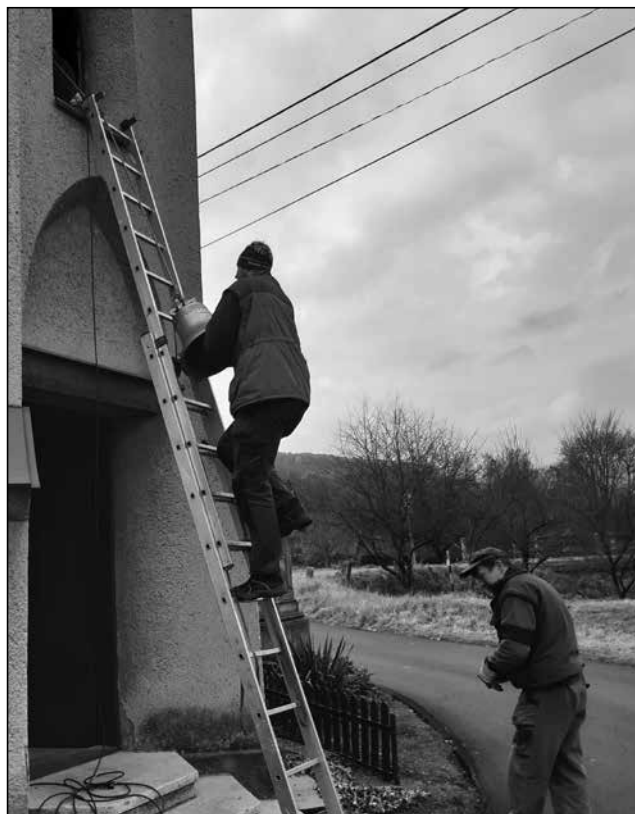
Umísťování zvonu na věž firmou IMPULS-B 16. listopadu 2021. Foto Jan Skalka.
