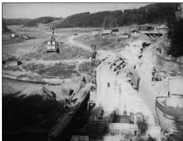
Lanový jeřáb, který dopravoval z pravého břehu Moravice beton do tělesa Kružberské přehrady, a který tak fascinoval autora příspěvku. Foto pochází z dobového krátkého filmu o stavbě přehrady.
