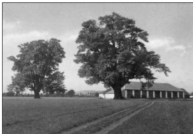
Stodola na Karlově před rokem 1945 se dvěma mohutnými soliterními černými topoly. Je zřejmé, že šlo o částečně zděnou stavbu. Jde o jediný nám známý pohled na objekty u Karlova. Foto z knihy Anderka M.
